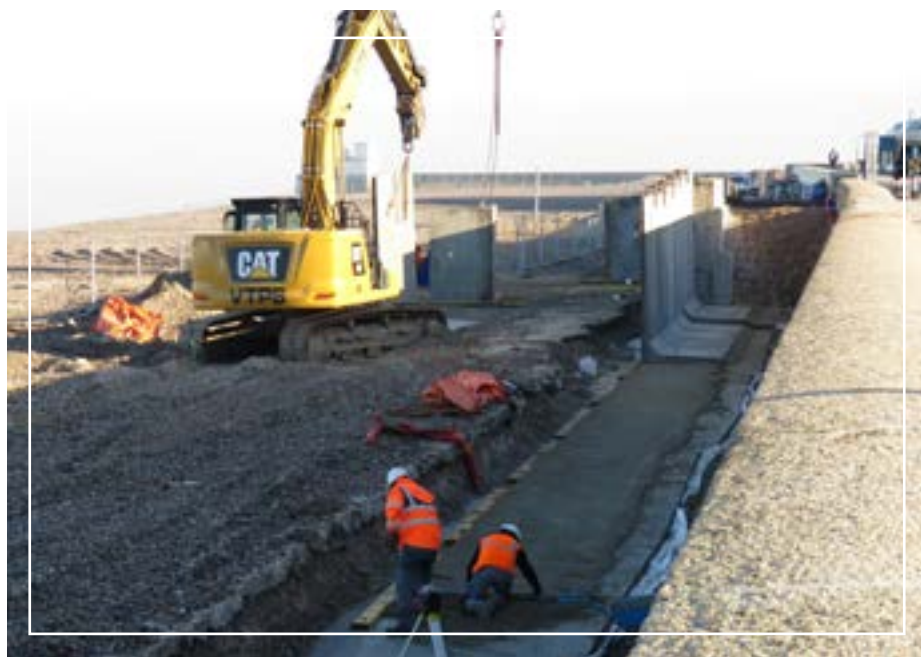
Un mur en «L» vient encadrer la longue rampe d'accès à la plage.
