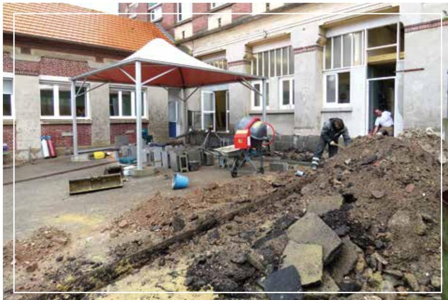
*Des tranchées ont été réalisées dans la cour pour permettre le passage du réseau d'évacuation.*
