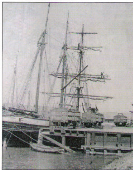
Navire en déchargement au quai du nouveau bassin
