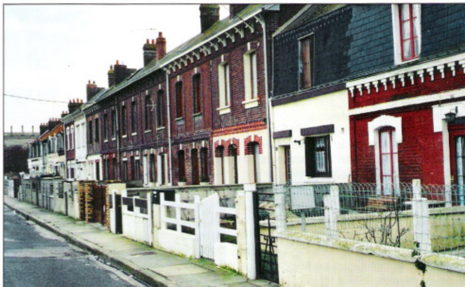
Rue de la Digue
