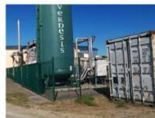
De plus, début 2018, le CVD s'est équipé d'une **plateforme de traitement des biogaz par charbons actifs imprégnés**.
