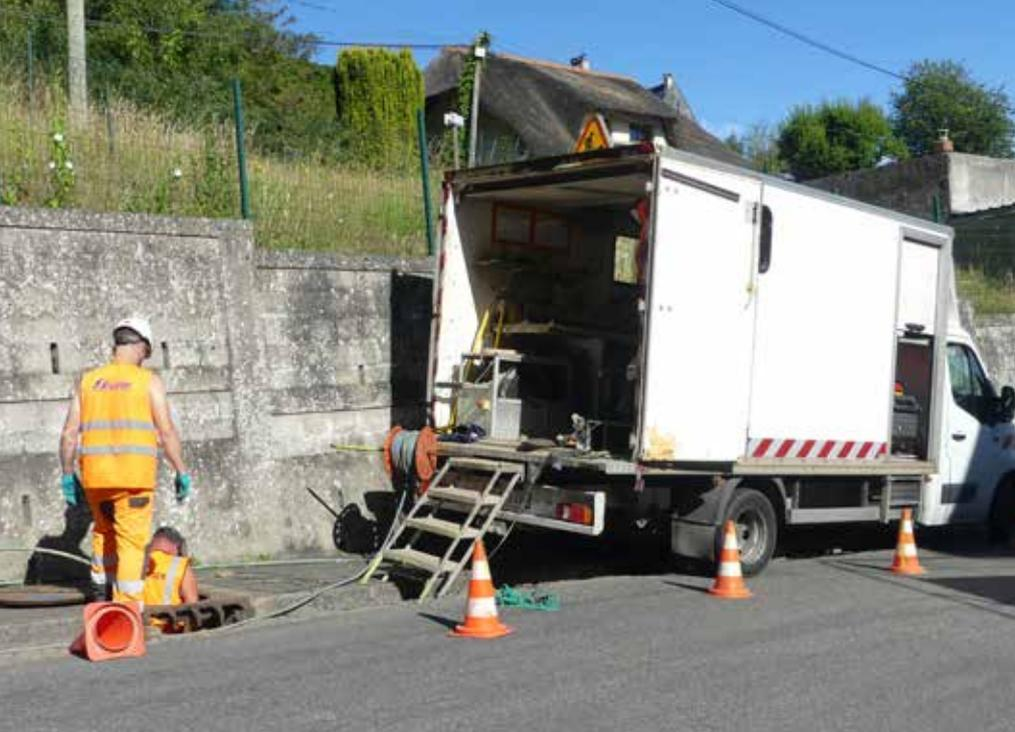
*La réhabilitation du réseau pluvial de la rue Suzanne a été réalisée cet été par une technique de chemisage. Il s'agit de rénover les tuyaux de l'intérieur, sans avoir à ouvrir de tranchée ni à remplacer le réseau.*
