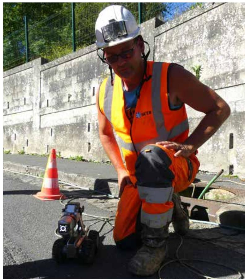
*Un engin équipé d'une caméra intervient dans le réseau.*
