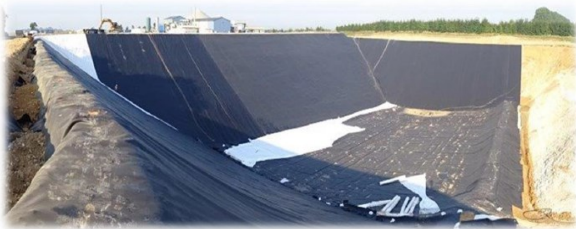
Figure : Barrière de sécurité passive
