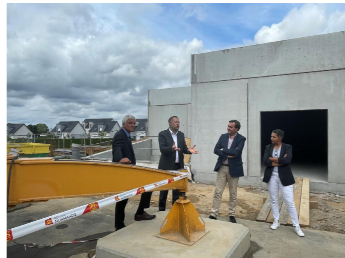
© Visite du chantier de la chaufferie Bois - Quincampoix - Août 2022 - SDE76
