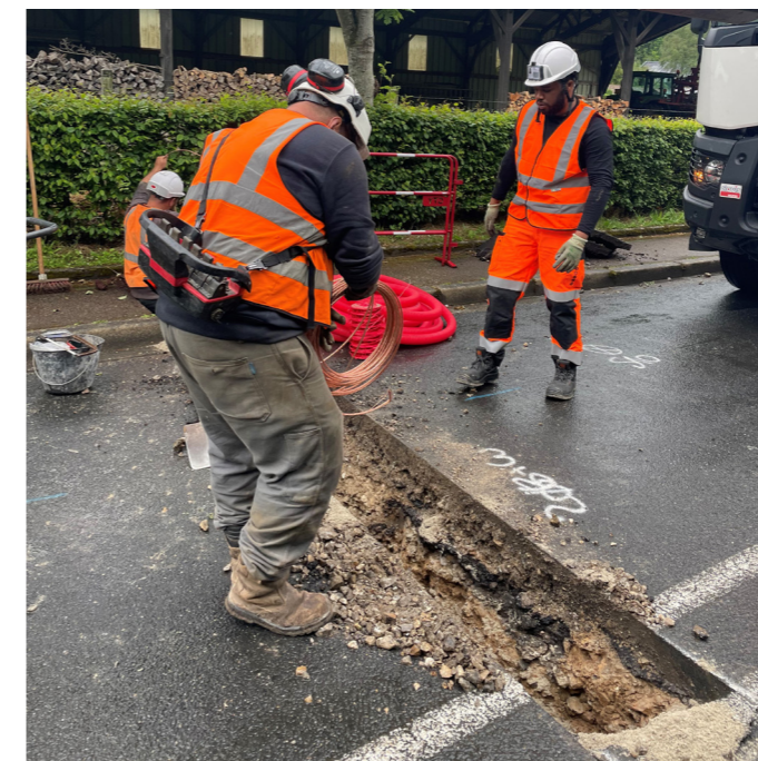
© Visite de chantier - Saint-Valery-en-Caux - Mai 2022 - SDE76
