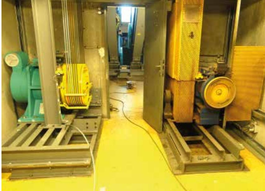
La nouvelle installation, à gauche, remplace le dispositif datant de 2006, à droite.
