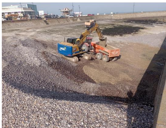
Extraction par moyens terrestres des sables le long du chenal (à gauche) et du piège à galet de la jetée Ouest du Port (à droite)
