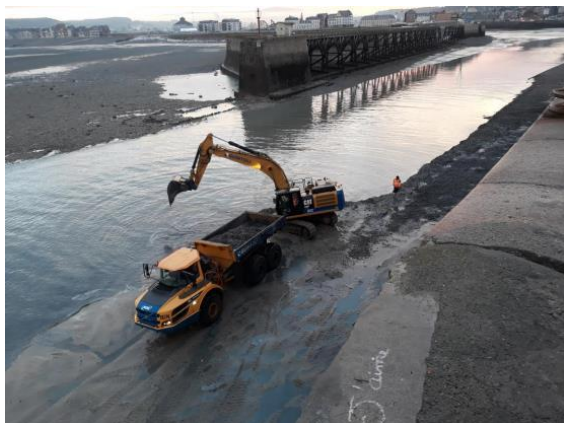
Extraction par moyens terrestres des sables le long du chenal (à gauche) et du piège à galet de la jetée Ouest du Port (à droite)
