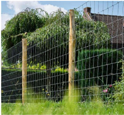
Figure 1 Grillage type grillage à moutons
